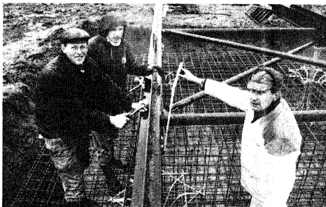
Fundamentarbeiten in Berlingsen.
