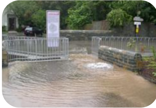
Überflutung durch Starkregen
