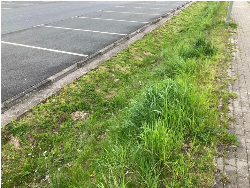
Entwässerung und Versickerung in/über die Grünfläche. Foto: Eva Lüning
