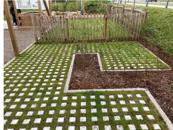
Wasserdurchlässiger Bodenbelag aus Rasenfugenpflaster. Foto: Mustergarten Stadt Soest, Eva Lüning
