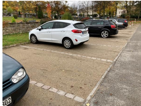
Parkplatzflächen aus wassergebundener Wegedecke. Foto: Eva Lüning
