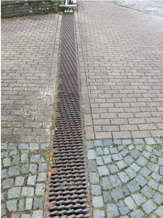
Entwässerungsrinne freihalten und ausreichend groß bauen. Foto: Eva Lüning
