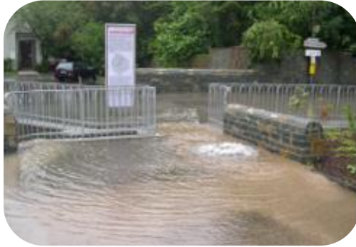
Überflutung durch Starkregen
