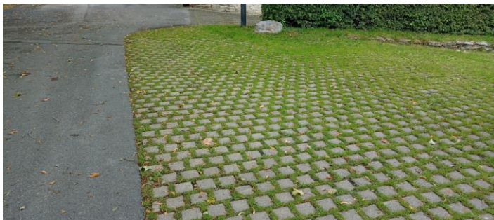
Wasserdurchlässiger Bodenbelag aus Rasenfugenpflaster. Foto: Eva Lüning
