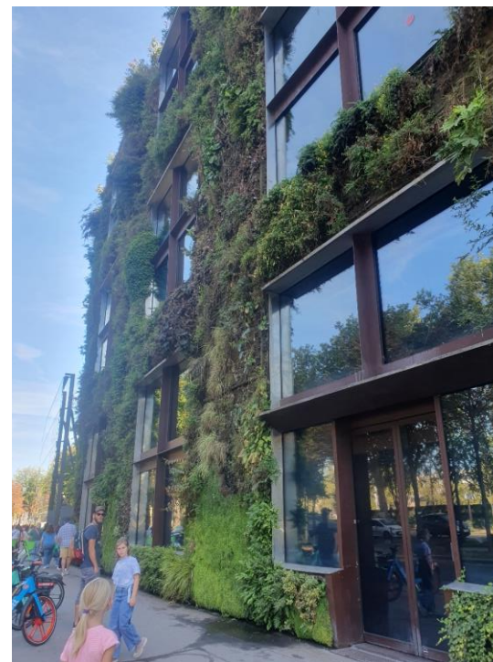
Dämmung durch Fassadenbegrünung. Foto: Anja Berg
