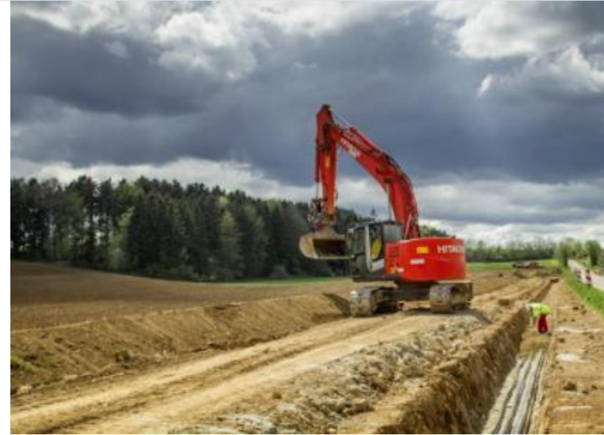
Gleichstrom-Erdkabel-Verlegung
